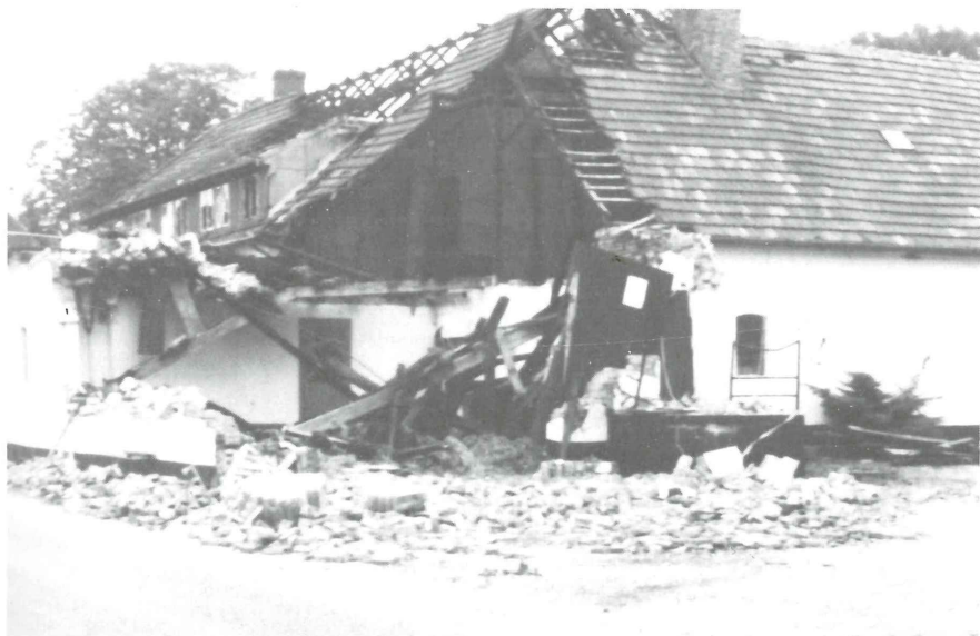
Der zerstörte Gasthof Meyn-Au am 10. Septmber, zwei Tage nach dem Großfeuer
