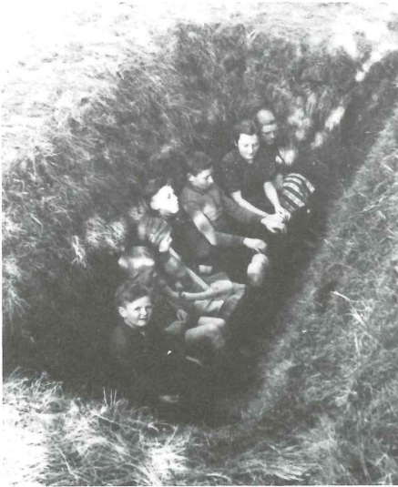
Splitterschutzgraben auf dem Meyner Schulhof während des Krieges
