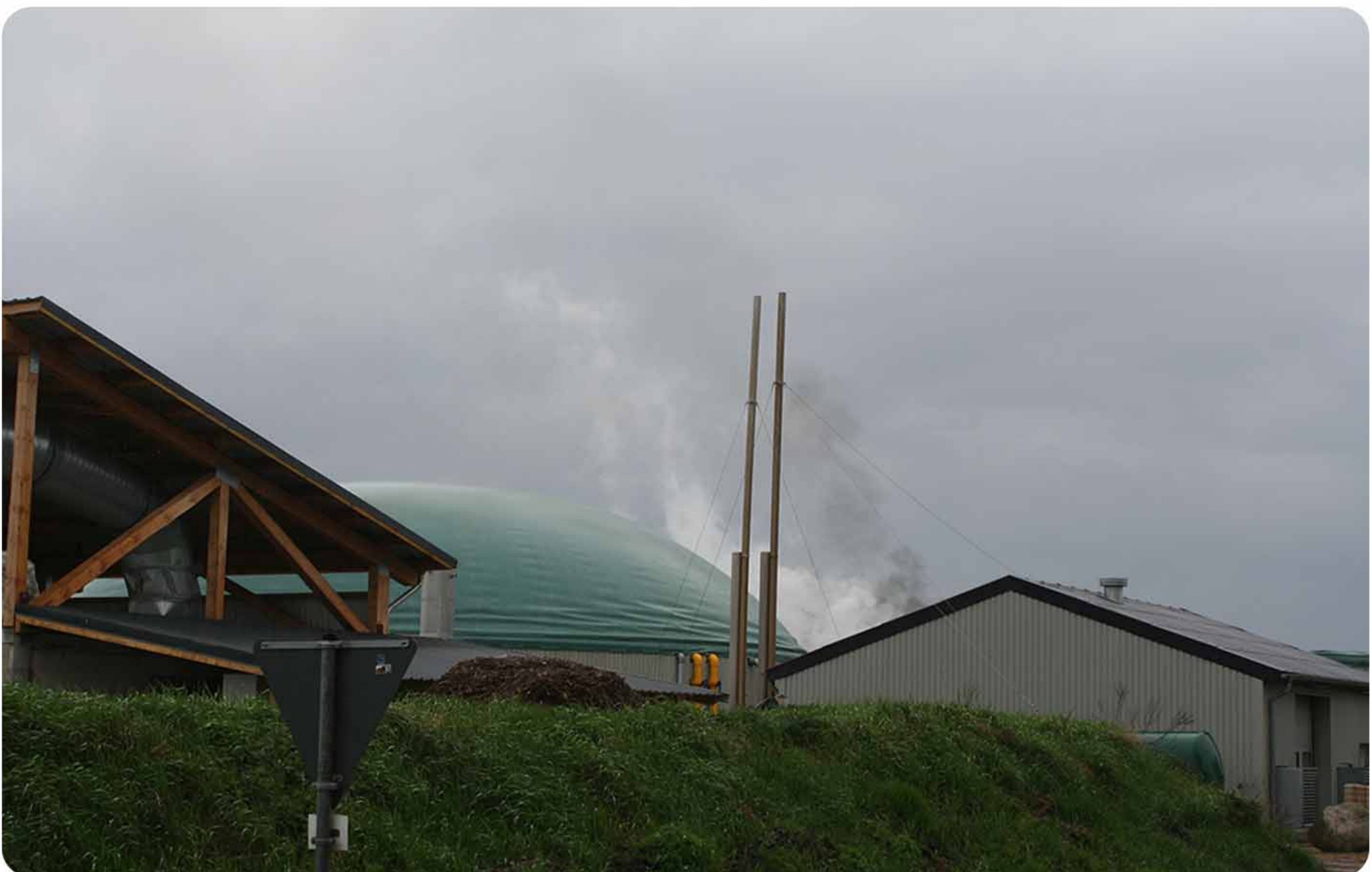
Lage auf Sicht, die Anlage bei Eintreffen der FF Meyn
